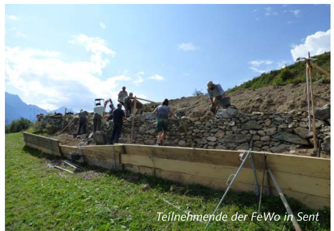
beim Wiederaufbau der Trockensteinmauer Sent
