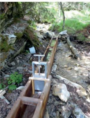
eingebauter Schieber zur Wasserregulierung
