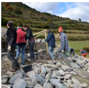
Trockensteinmaueraufbau
