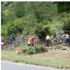
Trockensteinmauerbau in Lavin an der Umfahrungsstrasse
