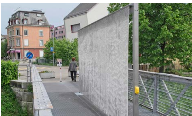
Abb. 20: Wasserschleier auf der Vorstadtbrücke
