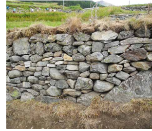
renovierte Trockensteinmauer in Guarda
