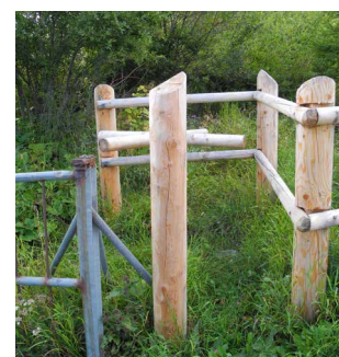
Weidedurchgang, erstellt als Massnahme im Pilotprojekt
